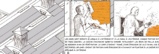
LES MURS SONT ENDOITÉS À L'ARÊTE À L'INTÉRIEUR ET À LA CHAÎNE À L'EXTÉRIEUR. CHAQUE FINITION EST EN TROIS COUCHES. LA COUCHE D'ACCROCHE (GROBETIC) ENROBE TOTALEMENT LES BRINS DE PAILLE AVEC AU MINIMUM 10 MM DE PÉNÉTRATION. LE CORPS D'ENDUIT TRAVÉ, D'UNE ÉPAISSEUR DE 20 À 30 MM, VISE À RATTACHER L'OSIUM. L'ENDUIT DE FINITION A UNE ÉPAISSEUR DE 4 À 10 MM ET UN FOUILLEUR À LA CASÈNE EST APPLIQUÉ À L'INTÉRIEUR.
