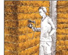
LES BOTTES DE PAILLE SONT RÉTAILLÉES ET CALBRÉES DIRECTEMENT SUR LE LIEU DE STOCKAGE. UNE DENSITÉ SUPÉRIEURE À 40 KG/M 3 EST REQUISE. L'HUMIDITÉ EST CONTRÔLÉE : ELLES DOIVENT ÊTRE INFÉRIEURE À 30% LORS DE LA MISE EN ŒUVRE.
