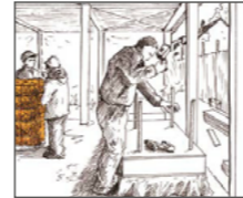
UNE LISSE BASSE EN BOIS MASSIF EST FIXÉE SUR LE SOUVRASSEMENT ET LA BARRIÈRE D'ÉTANCHÉITÉ POUR RÉALISER LE DÉPART DES MURS.
