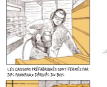
LES CAISSONS PRÉFABRIQUÉS SONT FIXÉS PAR DES PANNEAUX DÉRIVÉS DU BOIS.
