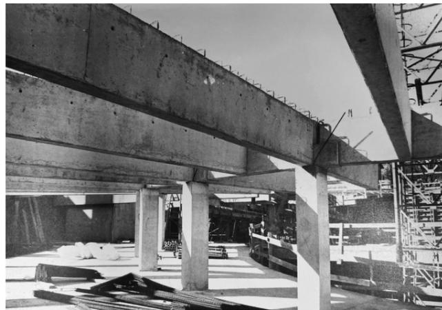
Système poteau-poutre préfabriquées rayonnantes en béton armé
