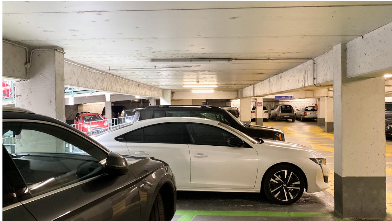
**Vue sur la partie centrale** : la dalle plan permet de relier la rampe montante et la rampe descendante à chaque niveau. Les points porteurs sont peu nombreux, ce qui explique que les poutres en béton retombent de 50 cm.
