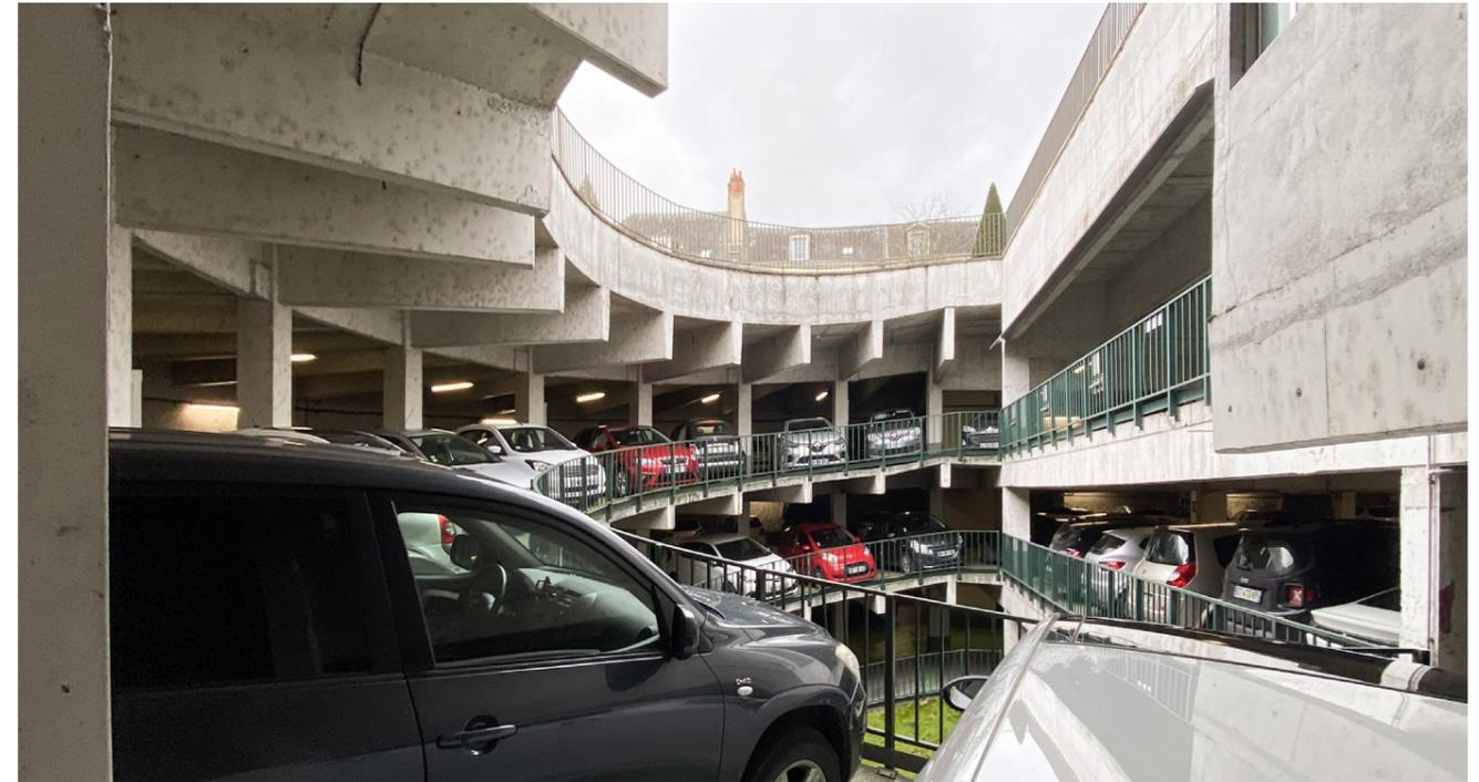
**Vue sur une trémie** : depuis ce point, on peut lire l'ensemble de la structure, et plus précisément le porte-à-faux de 4 m dirigé vers le centre de l'arc formé par les rampes. Les trémies servent à la ventilation et à l'éclairage naturel du parking.
