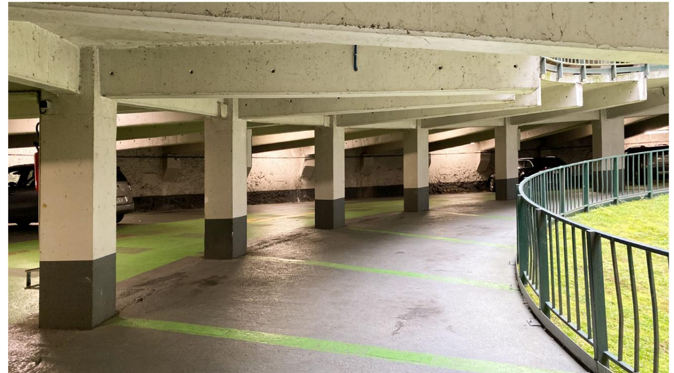
**Vue sur le porte-à-faux** : l'épaisseur de ce porte-à-faux permet d'installer une bande de stationnement.
