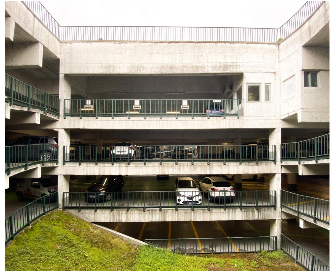
**Vue depuis une rampe, vers la partie centrale :** Le parking prend la forme d'un système hélicoïdal à double révolution. La dalle centrale, dont le sol est plan, permet de passer de la rampe montante à celle descendante à chaque niveau, évitant ainsi de parcourir l'ensemble du bâtiment pour sortir.
