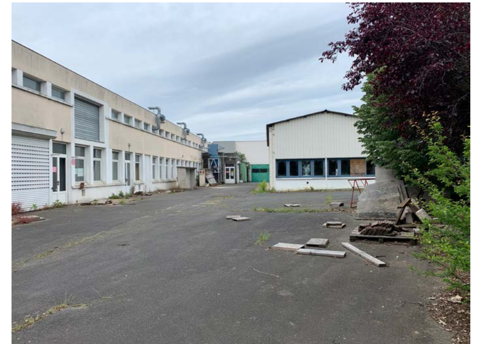
Bâtiments du CFA du BTP
