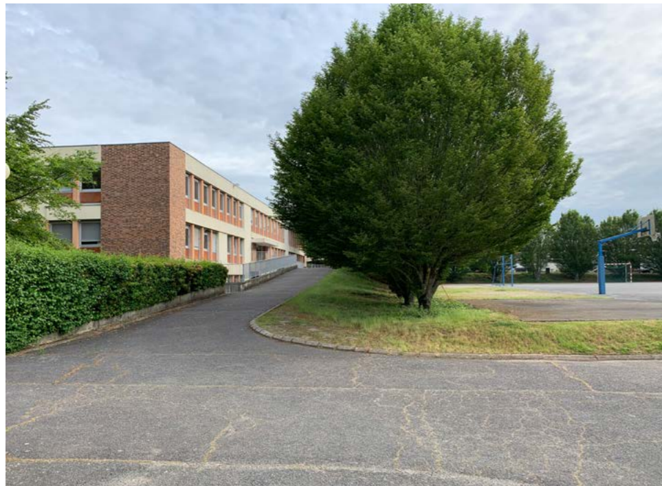
Bâtiments et cours du CFA CMA
